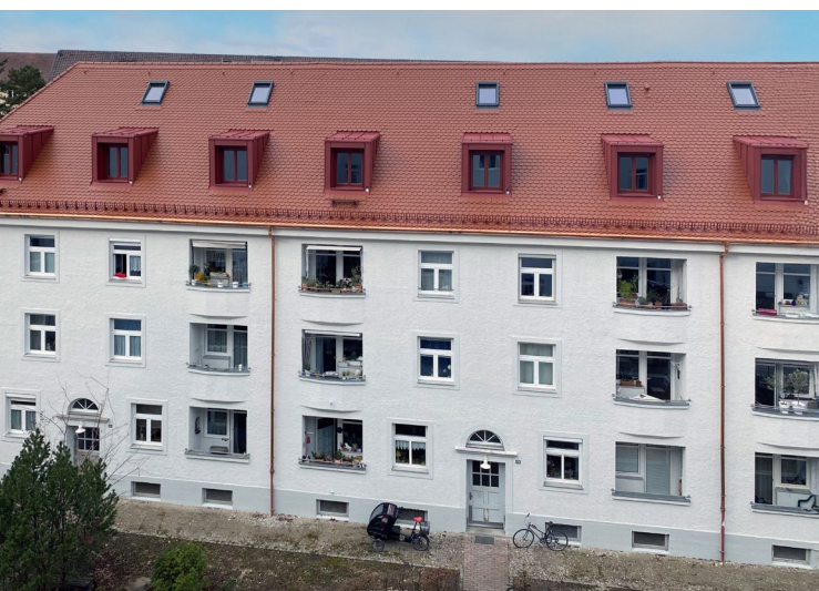
Schleißheimer Straße 153 a, b, c Neue Dacheindeckung mit oxidroten Gauben
