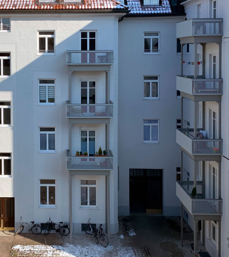
Schleißheimer Straße 145 – 155 Fertigstellung der Anbaubalkone
