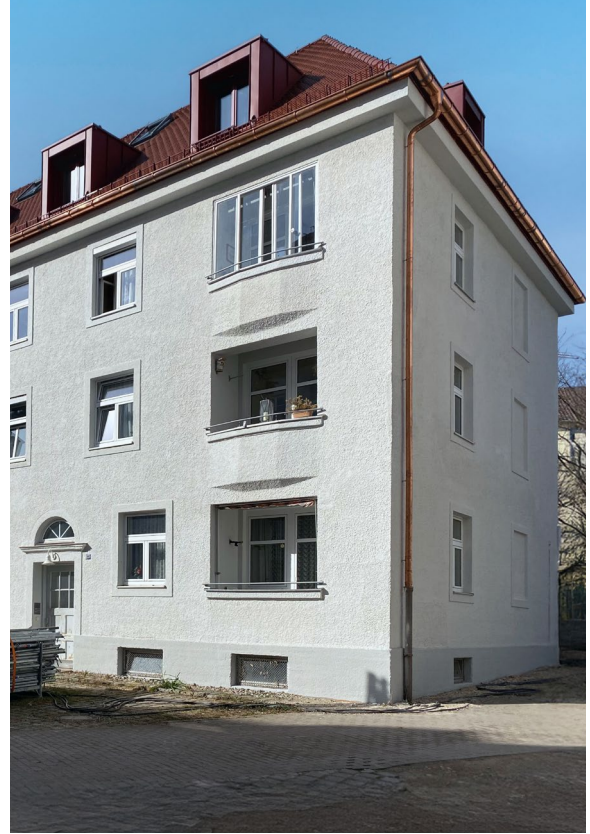
Schleißheimer Straße 153 c Fassadenarbeiten
