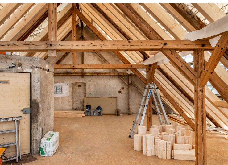
Schleißheimer Straße 153 a, b, c Der Ausbau der drei Dachgeschosswohnungen ist in vollem Gang
