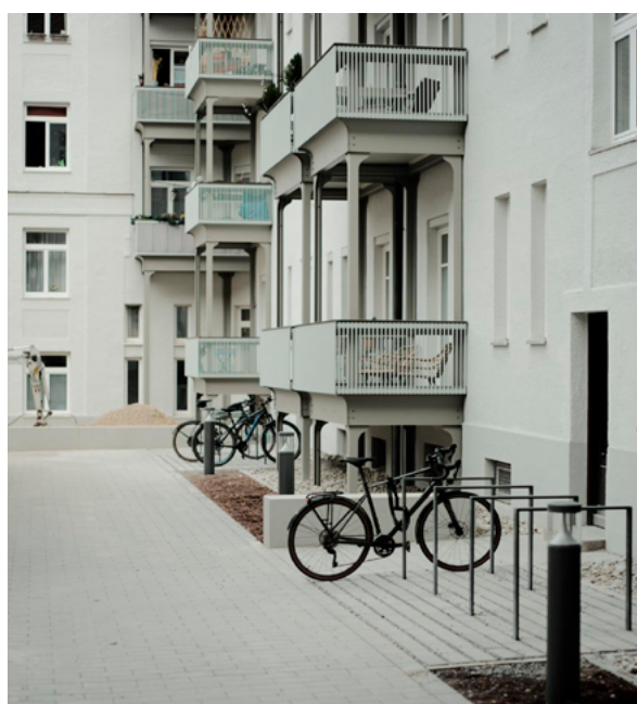
Balkone und Fahrradplätze Schleißheimer Straße, Clemensstraße
